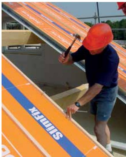
Tous les types, à l'exception de SlimFix Chevron, sont pourvus de 3 lattes à pannes de 20x30mm et d'une règle de gouttière de 20mm d'épaisseur, de hauteur variable en fonction de l'épaisseur de l'isolant.
